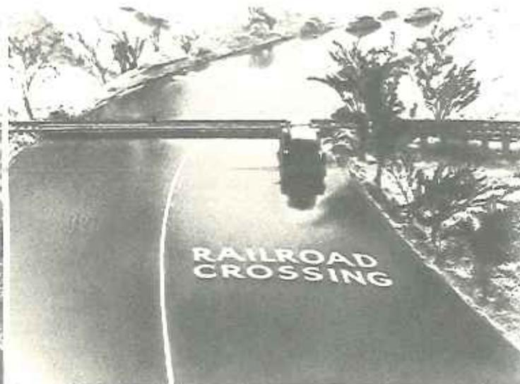
4. Effetto nocivo dei riflessi e dietro invisibile la scritta di preavviso di un incrocio a livello con la ferrovia. 5. Come viene vista la strada attraverso il dispositivo polarizzatore: i riflessi scompaiono, la scritta è chiaramente visibile.
